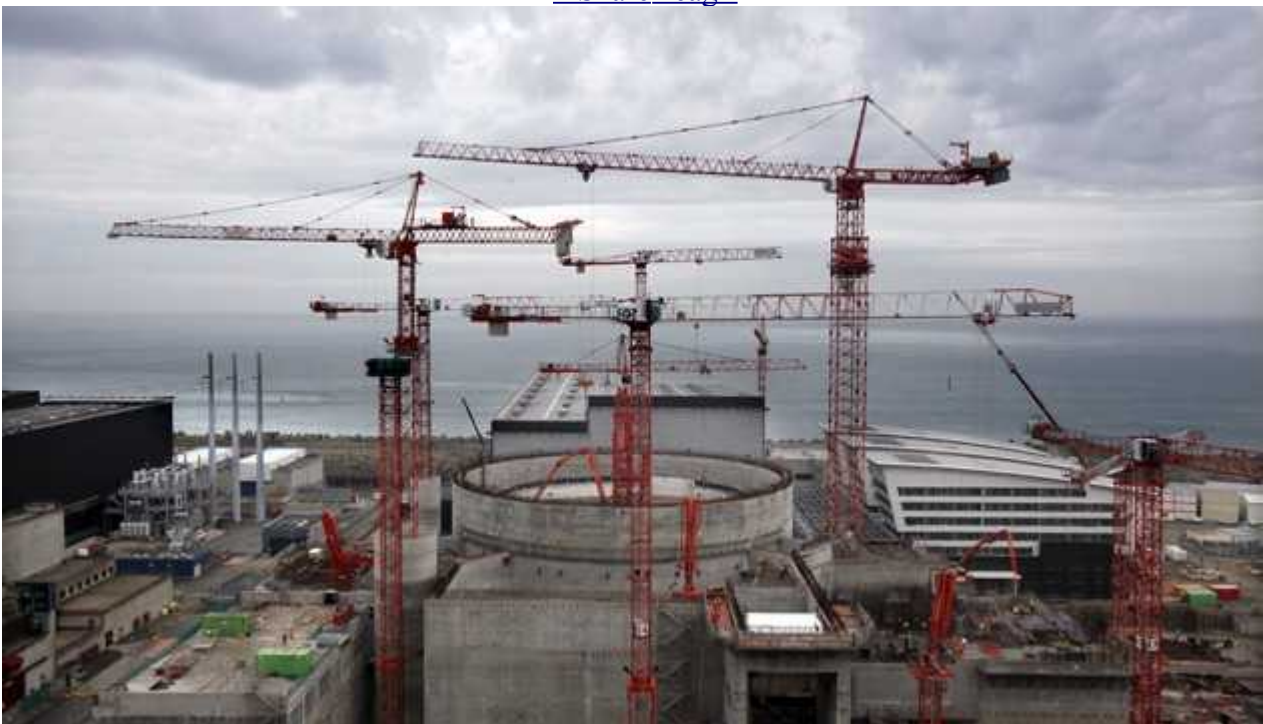
Le chantier de l'EPR de Flamanville, le 10 novembre 2012 (DESSONS/SIPA).
